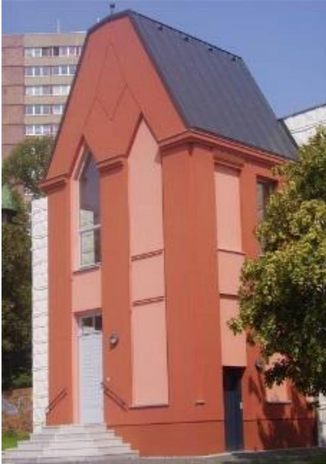
Dieses Gebäude in Frankfurt (Oder) beherbergt einen Personenaufzug, der nachträglich an ein bestehendes Gebäude angebaut wurde. So kam hier 2006 eine Dachdeckung in Doppel-Stehfalztechnik aus Titanzink zur Anwendung, die der Gestaltung des Hauptgebäudes angepasst ist.
