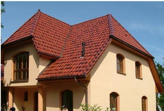
Bei der Eindeckung dieses Gebäudes in Schöneiche bei Berlin wurden geflammt glasierte Tondachziegel, die Flachdachpfanne Futura "Finesse-Antik" verwendet. Diese Ziegel weisen eine unterschiedliche Grauschattierung auf, so entstand der (gewünschte) Eindruck eines schon etwas betagteren Daches. Diese Arbeiten wurden 2005 durchgeführt.
