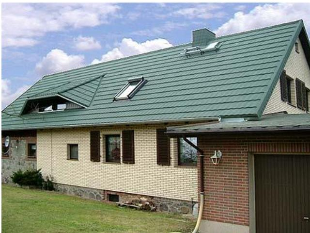
Dieses Einfamilienhaus in Jacobsdorf bei Frankfurt (Oder) wurde 2005 errichtet. Das Dach besteht aus einer Leichtmetalleindeckung im Ziegeldesign, realisiert mit dem System "Evergreen". Dieses Verfahren stellt eine Alternative zur herkömmlichen Dachsanierung dar.
