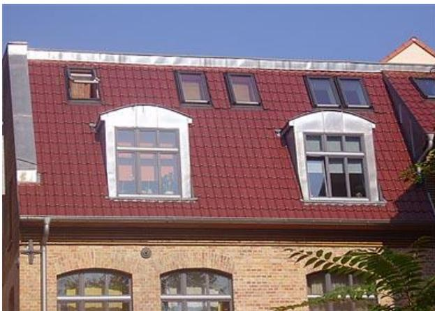
Im Rahmen einer Altbausanierung in Frankfurt (Oder), wurde 2004 dieses Dach mit einer Flachdachpfanne gedeckt. Bedingt durch die seltene Geometrie des Gebäudes erfolgte hier neben den Standard-Dachklempnerarbeiten eine Gaubenverblechung. Der Abschluss des Steildaches an das anschließende Flachdach wurde ebenfalls als Klempnerarbeit ausgeführt.
